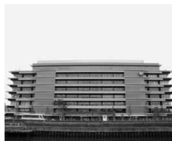
日本ヒューレット・パッカー 本社ビル
